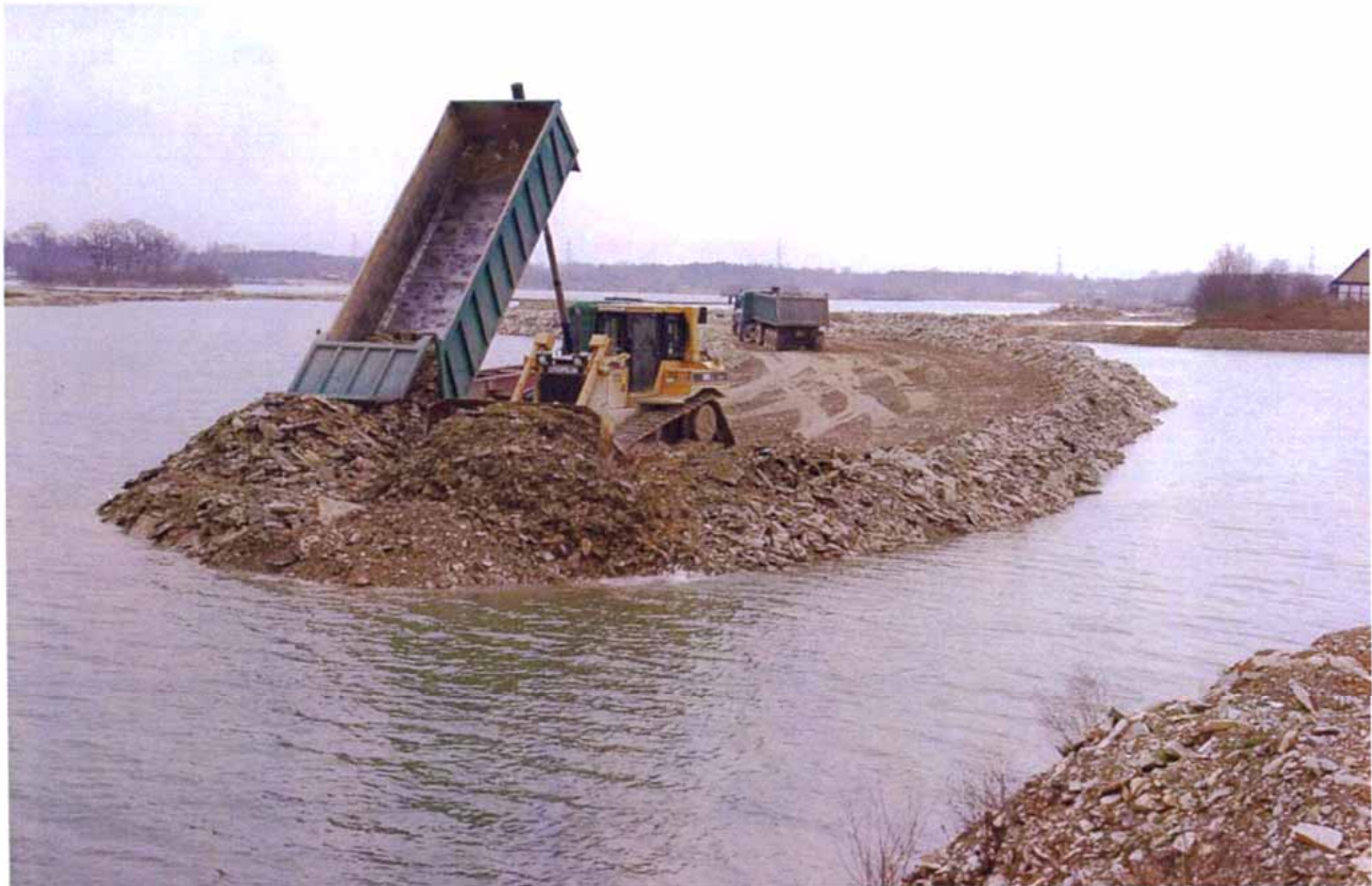
Felsdammvorschüttung direkt westlich des Holthofes
