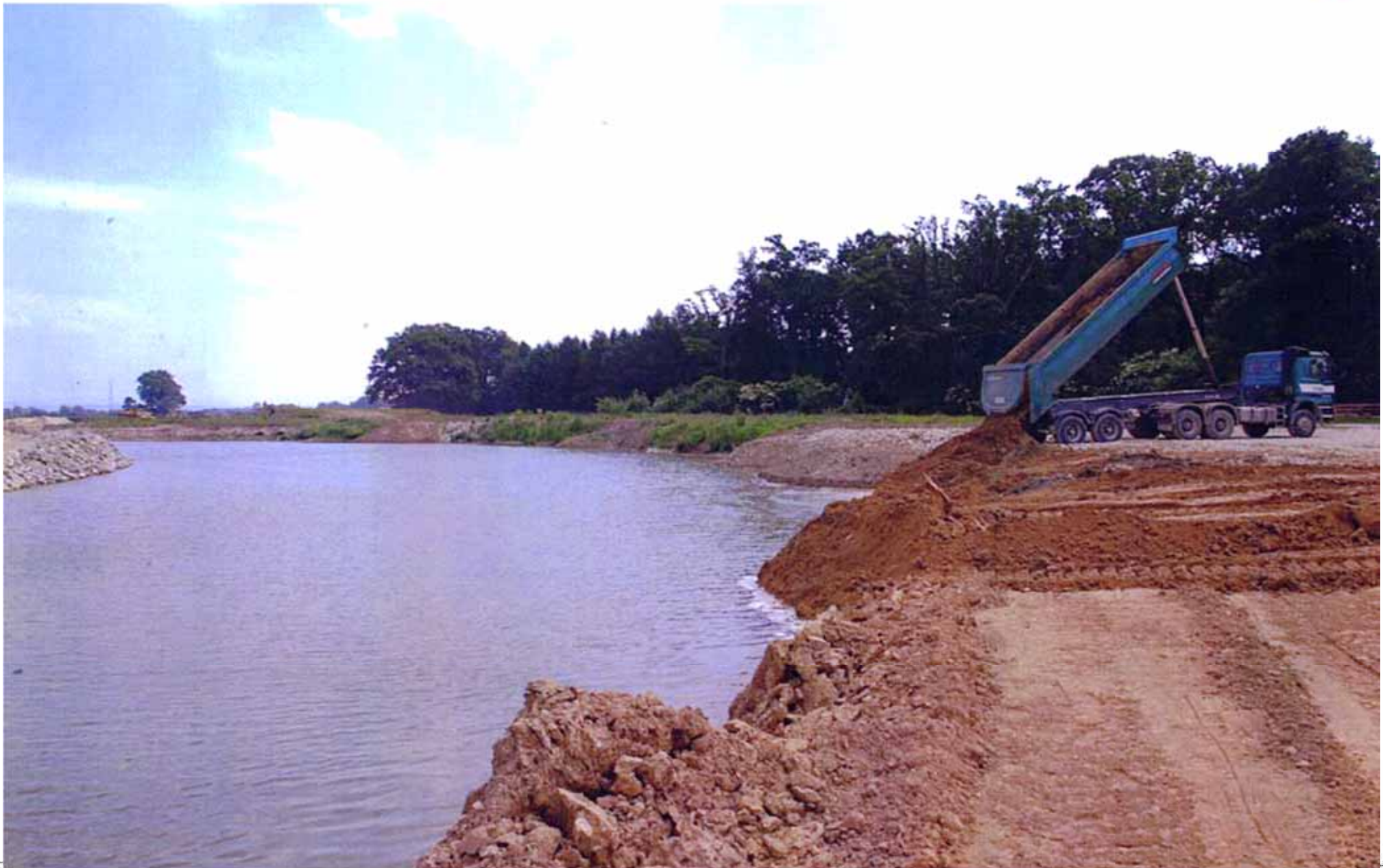
Hinterfüllung der Restwasserfläche östlich des Holthofes mit Mischboden
