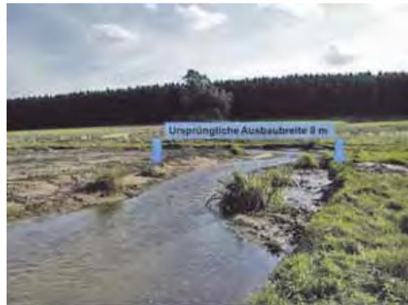
Abb. 4: Einengung des Fließquerschnitts durch Einbau von vor Ort entnommenen Hochstaudenplaggen (29.09.2001)
