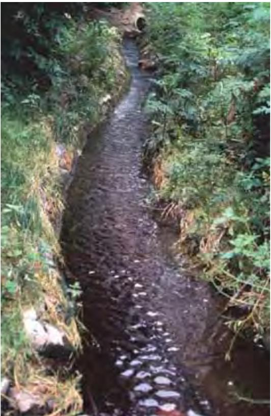
Abb. 4: Sohlschalen-Strecke im Abschnitt 5 vor Umbau (Foto: Wulfhorst, 05.06.2007)
