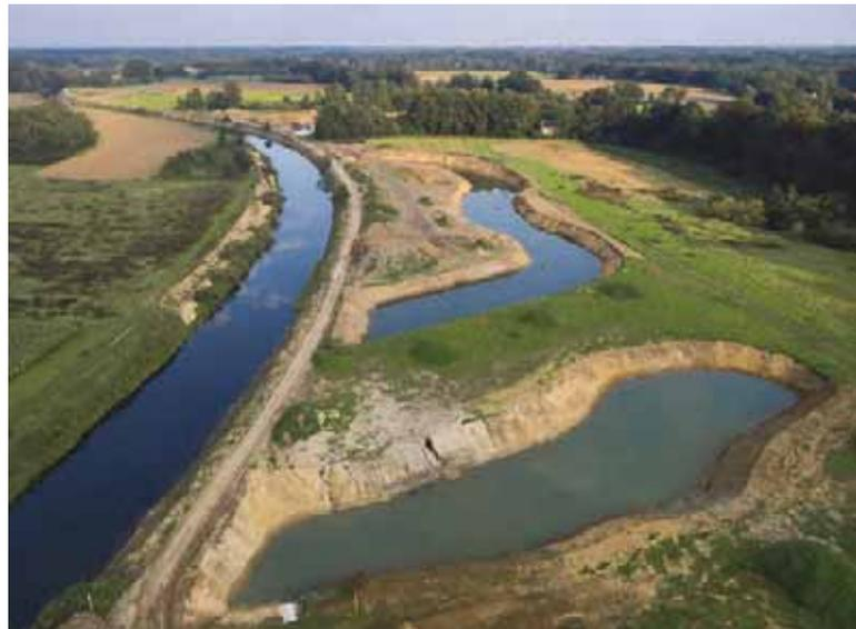
*Laufverlängerung der Ems unterhalb der Brücke Eimen in der Bauphase vor Abdämmung des Altverlaufes und Anbindung der neuen Flussabschnitte (im Vordergrund Gestaltung eines altarmähnlichen Gewässers)*
