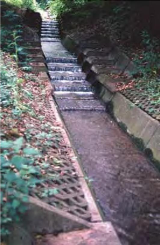
Abb. 2: Sohlstufen-Kaskade im Abschnitt 2 vor Umbau (Foto: Wulfhorst, 05.06.2007)
