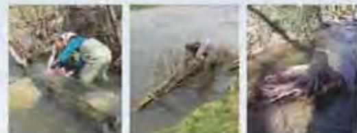
Die Gesteinsblöcke werden komplett durchbohrt und anschließend samt Stahlseil im Gewässergrund eingelassen. Anschließend werden an diese „Ankerpunkte“ die Totholzelemente befestigt. Damit die scharfkantigen Stahlseilenden nicht aufspießen, werden sie mit speziell angefertigten Endkappen aus Stahlrohr gesichert.
