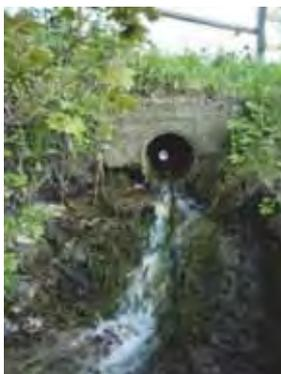
Abb. 4: Verrohrung unter Straße im Oberlauf der Wenne (Foto: Sondermann)
