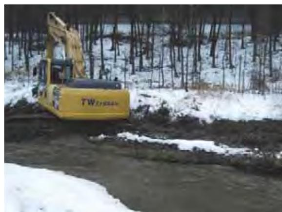
Foto 19: Totholzeinbau mittels Bagger
