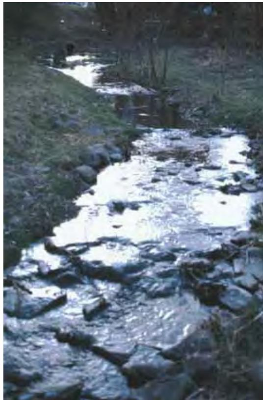
Abb. 5: Blockwurf-Strecke im Abschnitt 5 nach Umbau (Foto: Wulfhorst, 23.03.2011)
