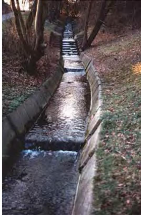
Abb. 3: Sohlstufen-Kaskade im Abschnitt 2 nach Umbau (Foto: Wulfhorst, 22.03.2011)
