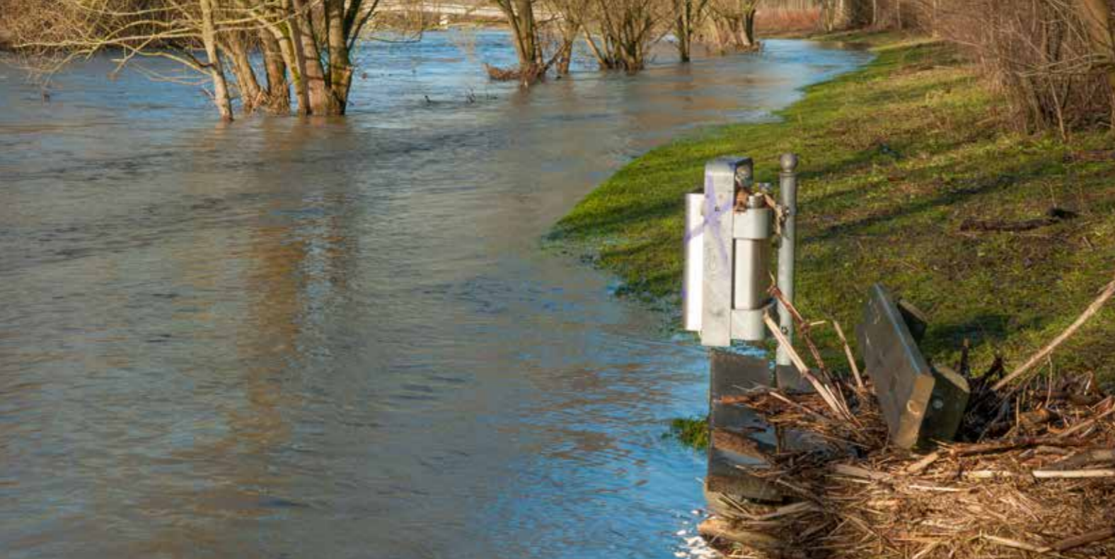
Durch Gewässerrenaturierungen dürfen die Hochwasserabflüsse nicht beeinträchtigt werden.
