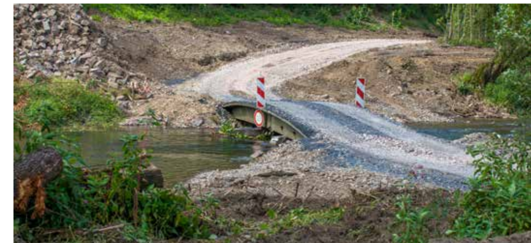
Bauzeitliche Behelfsbrücke: Die Maßnahmenumsetzung erforderte eine sorgfältig geplante Bodenlogistik. Lehmige Böden wurden abgefahren. Kiese und Schotter wurden zur Sohlanhebung wieder in den Flusslauf eingebaut.
