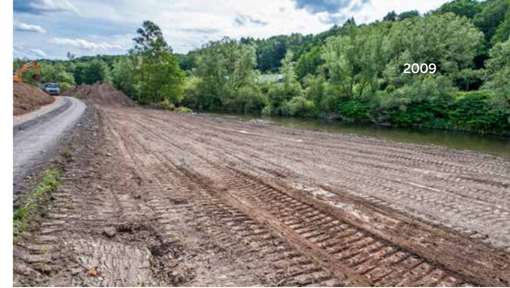
Der 3. Bauabschnitt im Bereich Binnerfeld: Im hinteren Bilddrittel ist bei Beginn der Umgestaltung der schmale Verlauf der ausgebauten Ruhr zu erkennen.
