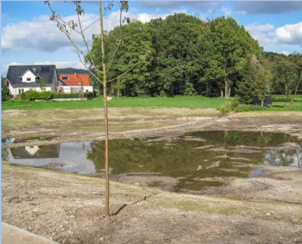
**OBEN:** Am Pulverbach wurde der Retentionsraum zum Rückhalt von Hochwasserabflüssen naturnah gestaltet.
